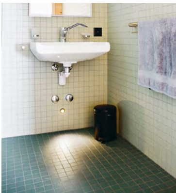
Automatisches Nachtlicht im Fussbereich, das von der offenen Badzimmertür aus sichtbar ist.
