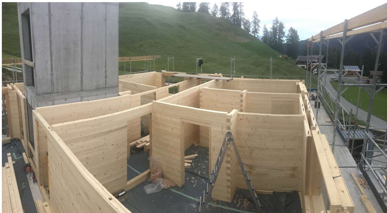
Bild 2: Aus mehr als 10'000 massgefertigten Einzelteilen bauten die Zimmerleute in drei Wochen unser Haus!
